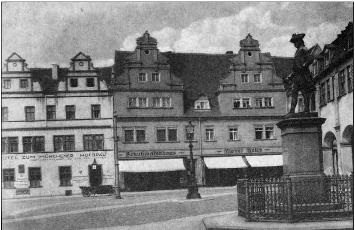
Das Schuhwarenhaus Mayer Reich, vor dem Umbau Ende der 1920er Jahre
