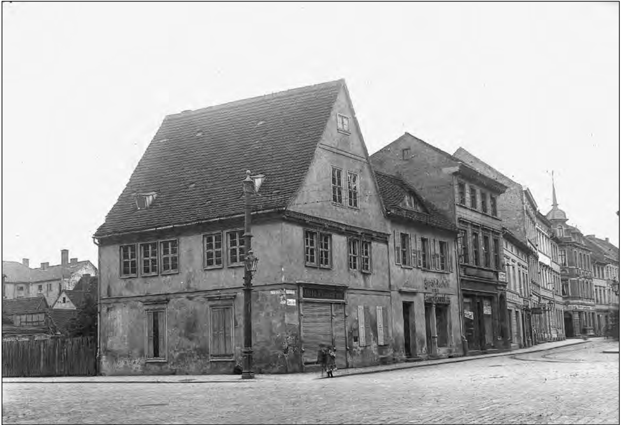
Eckehaus Askanische Straße/Steinstraße vor dem Abriss 1905 (für den Neubau des Gemeindehauses)
