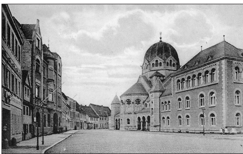
Steinstraße: Die neue Synagoge mit dem Gemeindehaus (rechts) an der Ecke Askanische Straße (um 1910)
